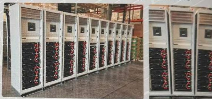
Exemple d'une réalisation avec 266 kWh de stockage / 135 kVA d'onduleurs
